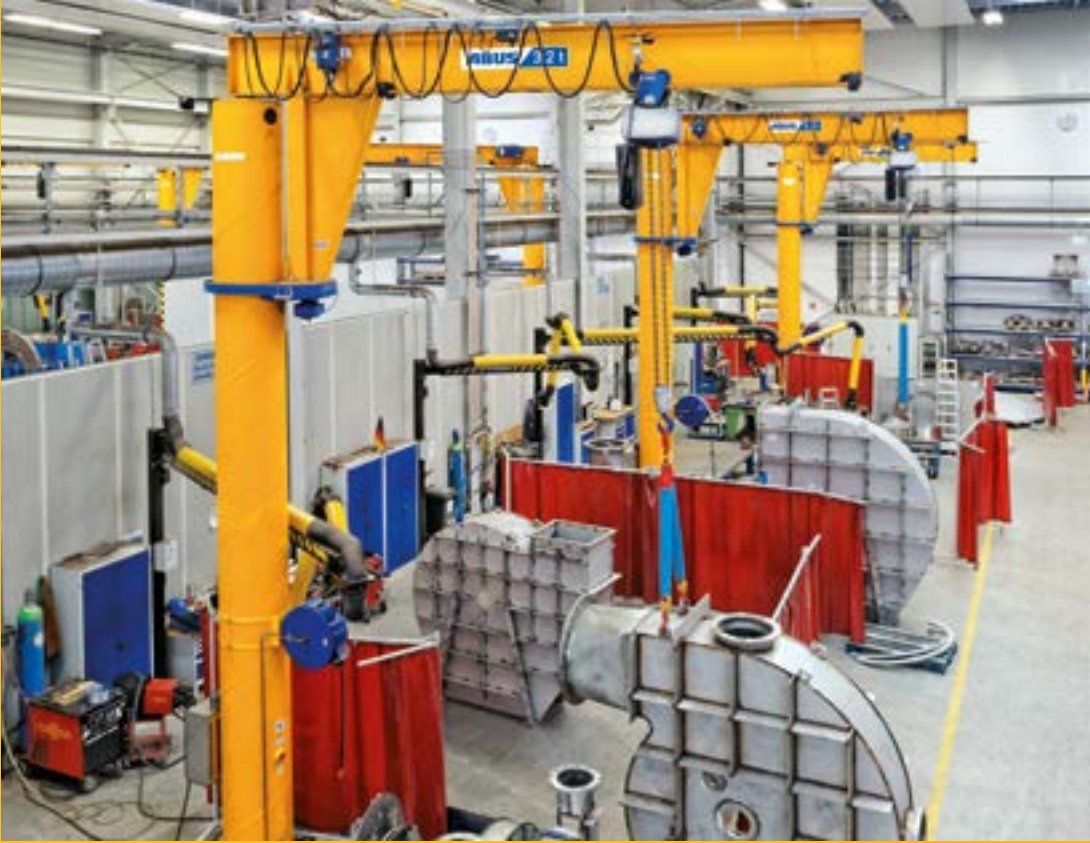
Søyle og veggsvingkraner
