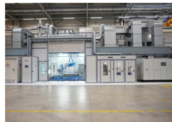
Korrosjonsbeskyttelse og overflatebehandling ved bruk av vannbasert maling
